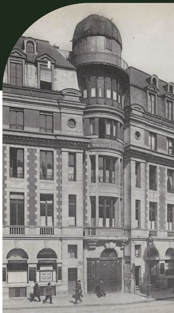
1 er local de l'école rue Serpente
